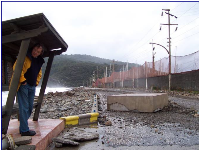
Bloc de béton projeté sur la route (hiver 2003-2004)
